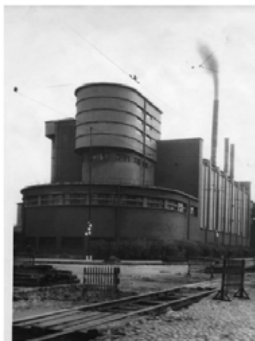
Ил. 3. Силовая станция фабрики «Красное знамя», 1925–1926 гг.
