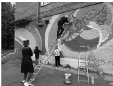
Ил. 2. Работа над росписью фасада ГДКБ № 3. 2023.
