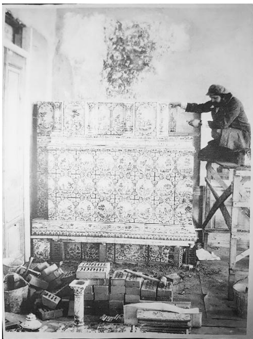
Ил. 1. Ю. Новиков при сборке изразцовой печи в Секретарской (средняя часть главного фасада). 1981. Фото из архива ГМЗ «Петергоф»
