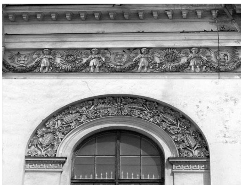
Ил. 2. Лепнина фасадов Троицкого собора. г. Санкт-Петербург
