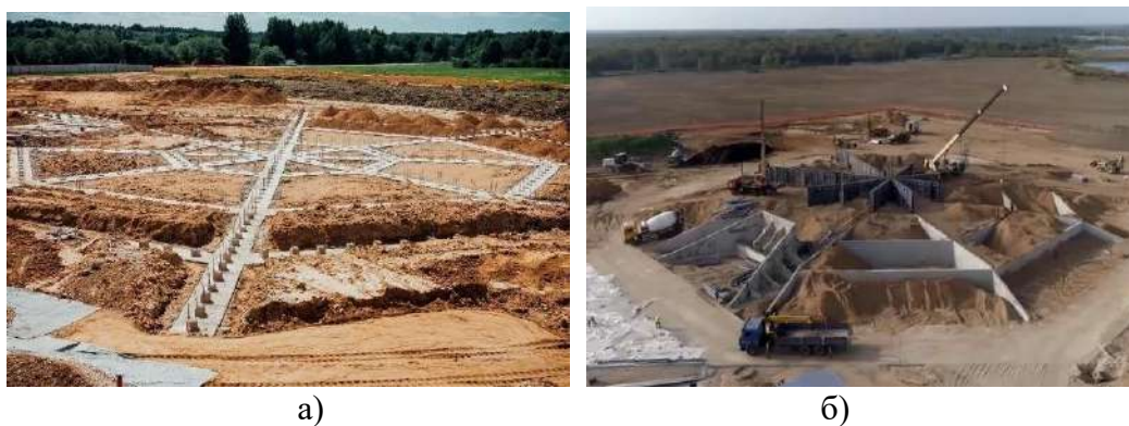
Рисунок 4. Фундамент мемориальной площади: а – фундамент кургана на сваях; б – фундамент насыпного кургана Figure 4. Foundation of the Memorial Square: a – foundation of the mound on stilts; b - foundation of the bulk mound
