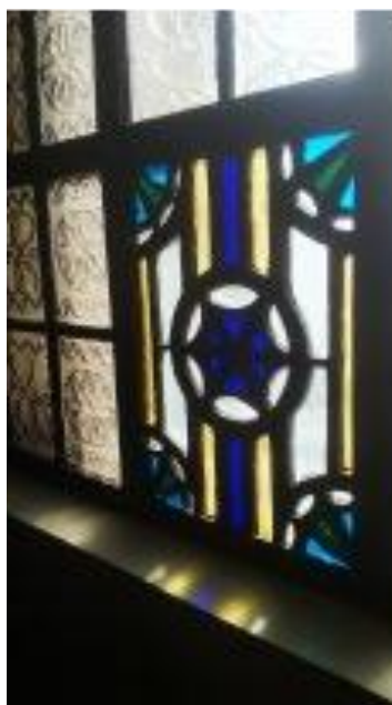
Рисунок 1. Витраж на бетонной связке с элементами, выполненными по технологии «кастинг»
