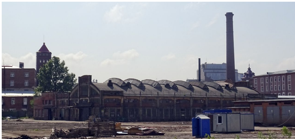
Рисунок 7. Кузнечный цех «Государственного механического завода им. Карла Маркса» (Большой Сампсониевский пр., д. 66, лит. О) - объект культурного наследия регионального значения. Здание нового кузнечного цеха построено в 1928 г. по проекту архитектора Льва Петровича Шишко
