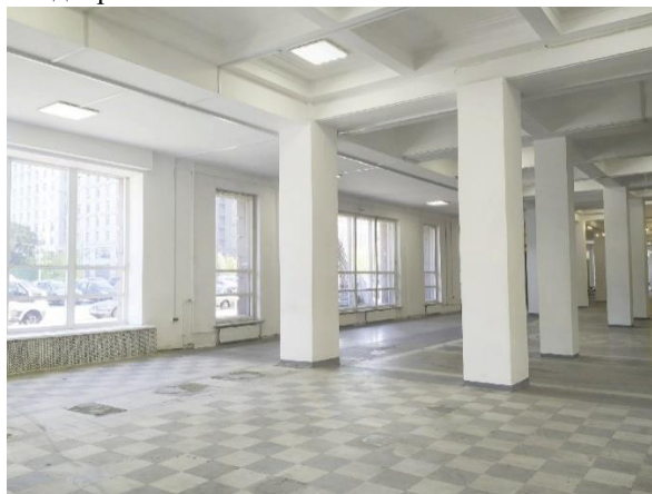
Рис.3. Фотофиксация проектируемого помещения
