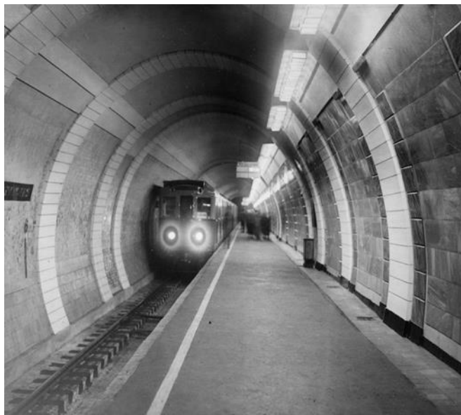
Рис.4. Перронный зал станции метро “Дзержинская” в Москве. 1934 г.
